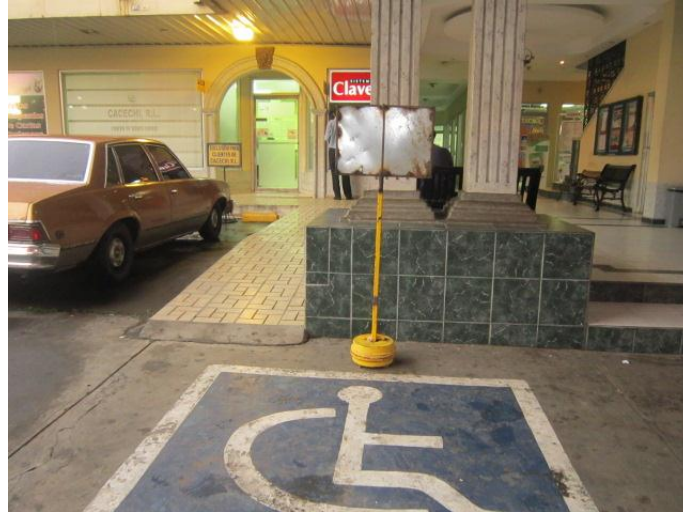
Rampa y estacionamientos para discapacitados
