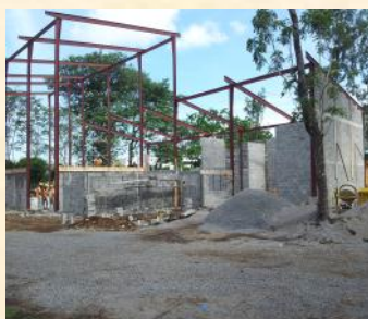
Esta es la estructura que se adelanta para instalación del centro de “Producción y Procesamiento de Semilla Certificada Arroz” como producto de las investigaciones en la que participa la universidad
